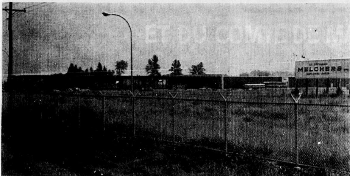
Berthierville : (G.T.) — Les Distilleries Melchers de Berthierville sont à nouveau en pleine période d'expansion. On voit ici la construction de nouveaux entrepôts sur les terrains de la compagnie.
