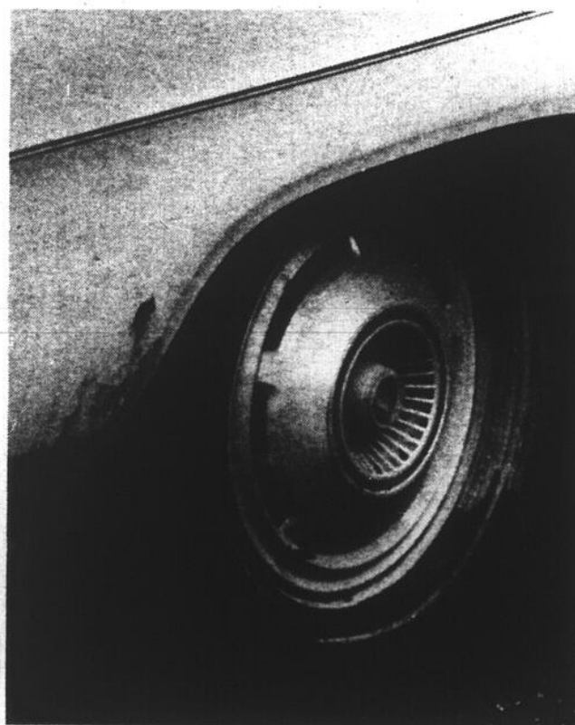
Des consommateurs ont obtenu gain de cause dans des cas de rouille prématurée de leurs voitures. Ces causes ne règlent cependant que des cas individuels.
