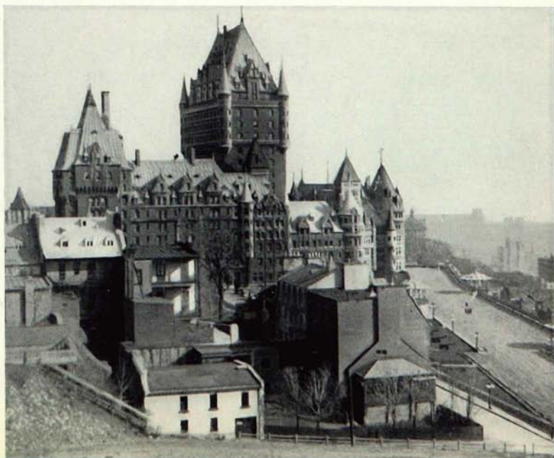
The Château Frontenac, Québec.
