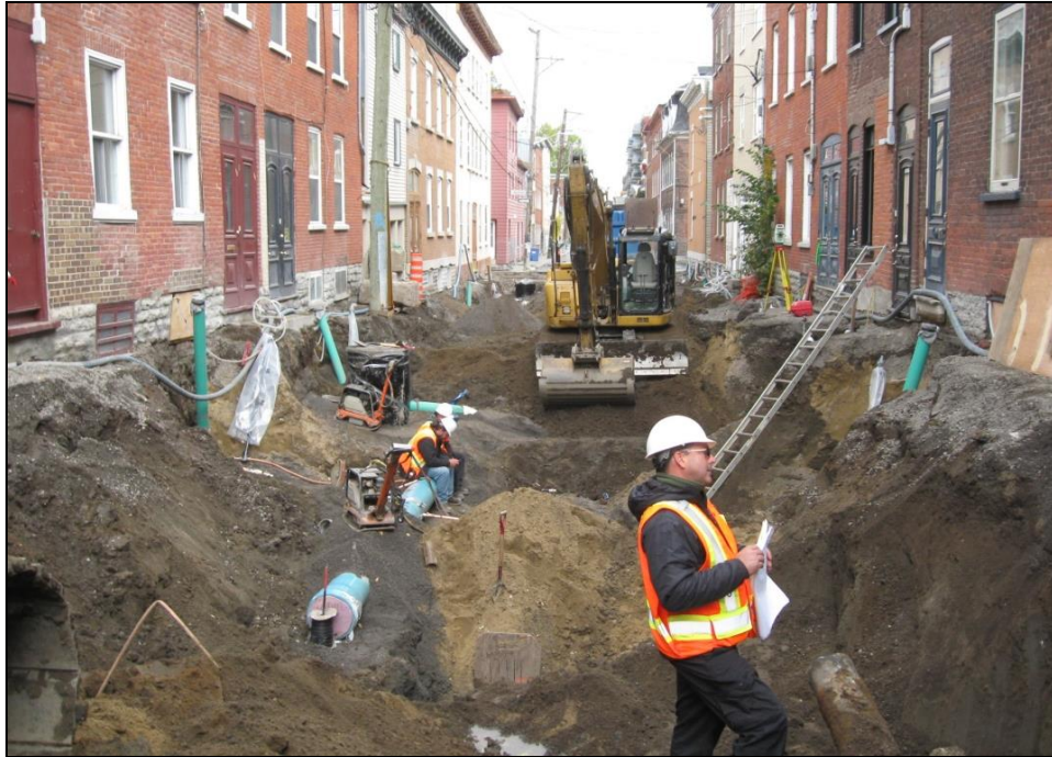
Photo 88. Vue d'ensemble de la sous-opération 4A en cours d'excavation, vers l'est (CeEt-884-2015-4-001)
