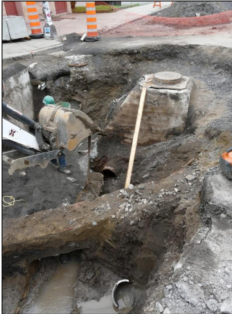
Photo 29. Vue d'ensemble du vestige 1A100 correspondant à un regard en brique encore en fonction situé à l'angle de la voie ouest du boulevard Langelier et du boulevard Charest, vers l'est (CeEt-931-2015-1-038)
