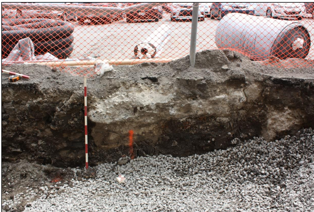
Photo 9. Vue de la portion est du vestige 1A103, vers le sud (CeEt-939-2015-1A-068)
