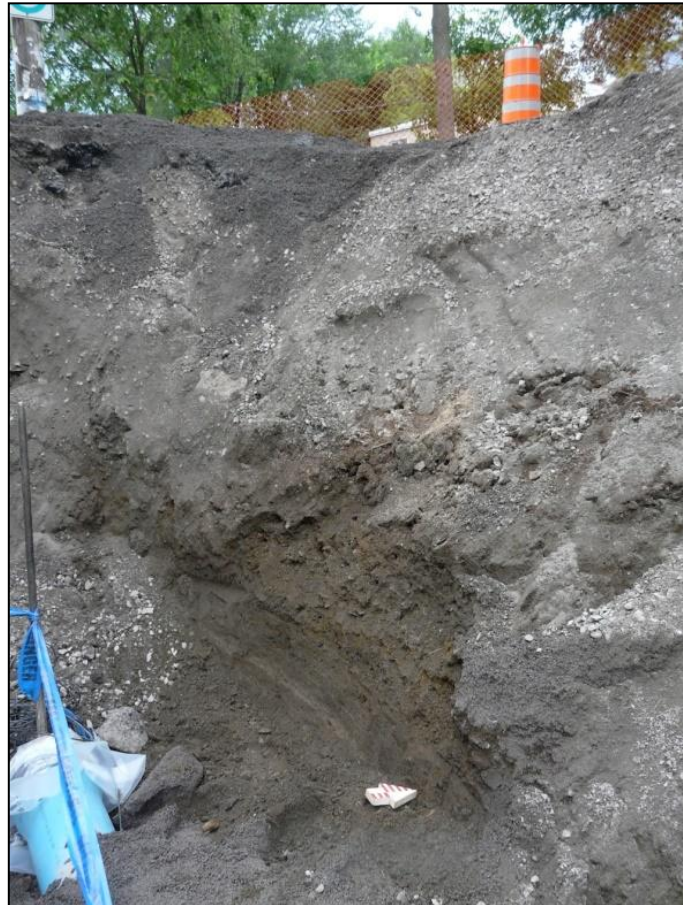
Photo 82. Vue d'ensemble de la paroi nord de la sous-opération 2B, vers le nord-ouest (CeEt-884-2015-2-023)
