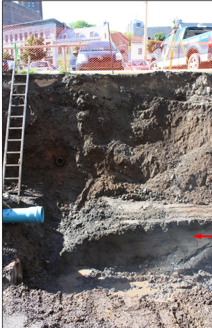
Photo 3. Paroi nord de la sous-opération 1A près du chaînage 1+120, vers le nord-nord-ouest (CeEt-939-2015-1A-007). La flèche rouge indique le sol naturel.
