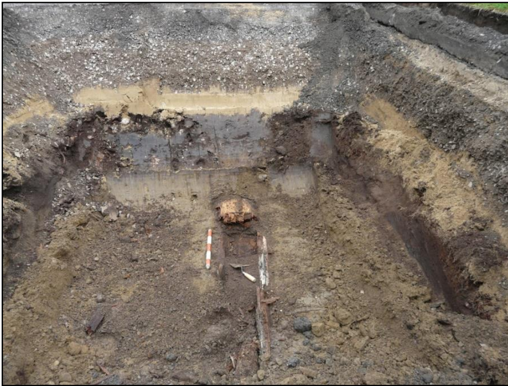
Photo 37. Vue d'ensemble de la canalisation de bois 1A104 mise au jour dans la voie ouest du boulevard Langelier, au nord de la rue Demers, vers le nord (CeEt-931-2015-1-009)
