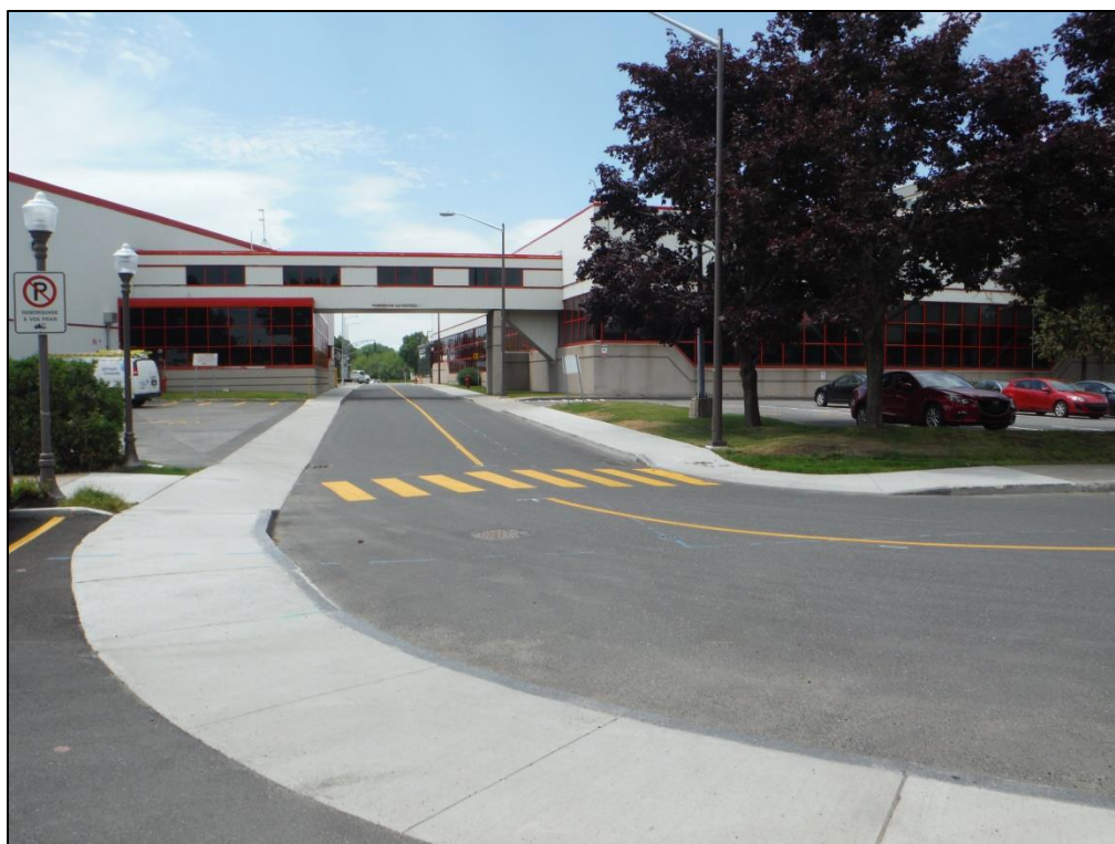
Photo 11. Vue d'ensemble de la portion ouest du projet de la rue du Chalutier, vers le sud-ouest (2015-Chalutier-002)
