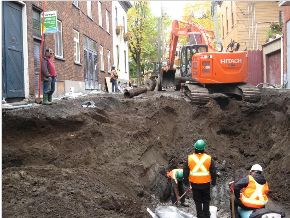
Photo 89. Vue d'ensemble de la sous-opération 4B avant la réalisation de l'inventaire, vers l'ouest (CeEt-884-2015-4-007)
