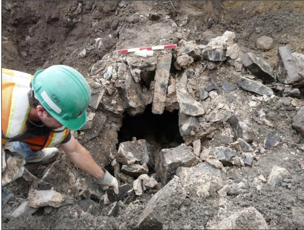
Photo 45. Vue en coupe du conduit voûté en pierre 1A102, vers l'est (CeEt-931-2015-1-062)
