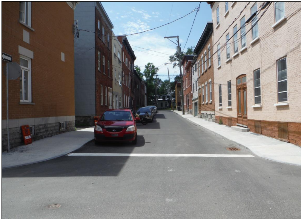
Photo 103. Portion est du segment de la rue du Roi qui a fait l'objet de travaux et correspondant au site CeEt-933, vers le sud-ouest (CeEt-933-2015-1-001)
