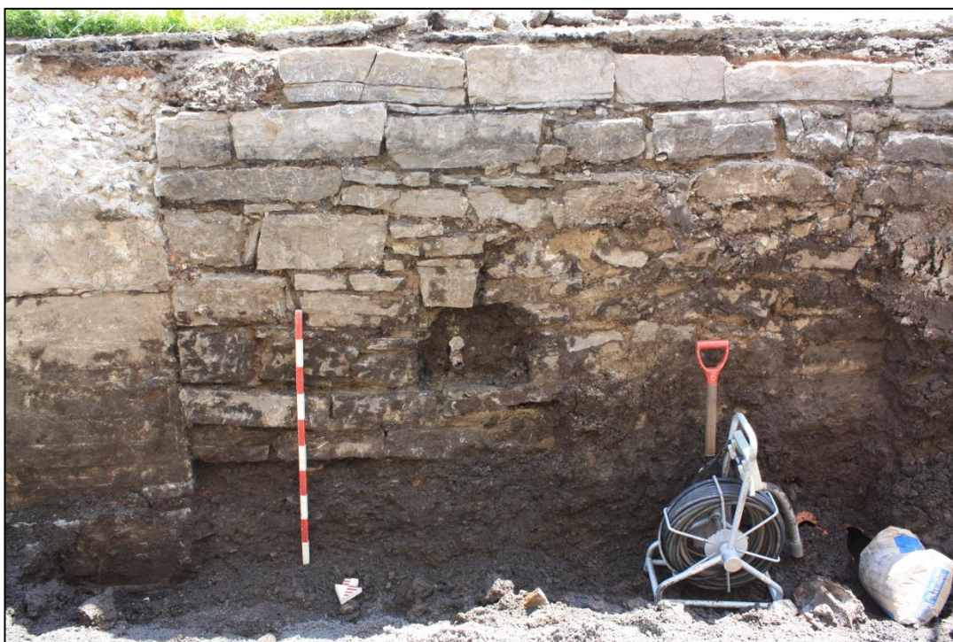
Photo 7. Vue de la portion est du vestige 1A102, vers le sud (CeEt-939-2015-1A-029)
