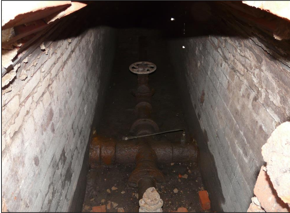
Photo 84. Vue de l'intérieur du vestige 2A100 qui montre les vannes de l'aqueduc principal situé au nord du boulevard Charest, le long de la voie ouest du boulevard Langelier, vers l'est (CeEt-884-2015-2-015)
