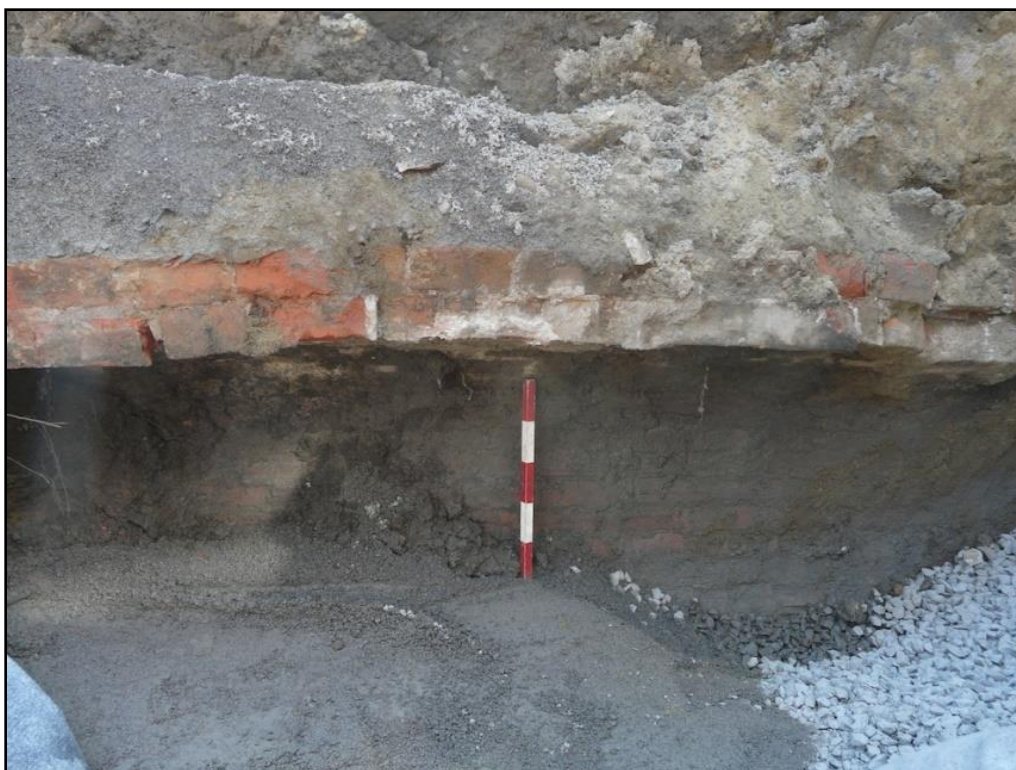
Photo 31. Vue de l'intérieur du vestige 1A101 correspondant à un conduit circulaire en brique ( Brick Barrel ) partiellement détruit et rempli de pierres concassées (0-3/4), situé à l'angle de la voie ouest du boulevard Langelier et du boulevard Charest, vers l'est (CeEt-931-2015-1-046)
