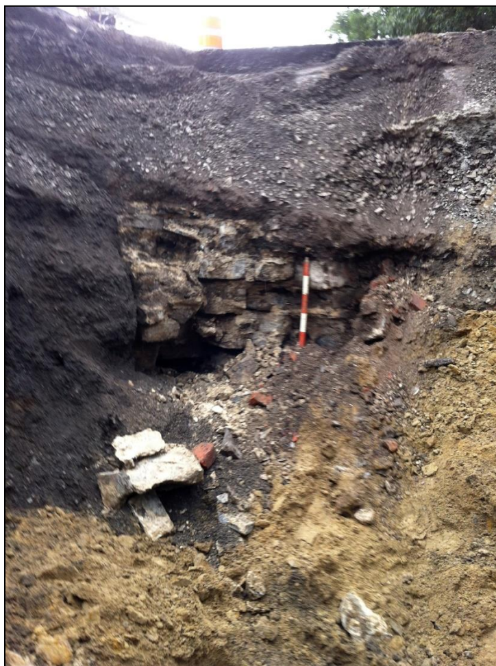
Photo 78. Vue rapprochée du vestige maçonné en pierre 1A100, vers le sud (CeEt-932-2015-1A-002)
