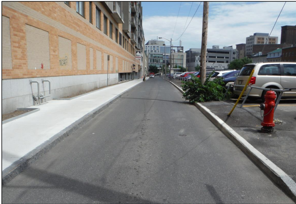
Photo 1. Vue d'ensemble du segment de la rue De Sainte-Hélène qui a fait l'objet de travaux d'excavation de masse, vers le nord-est (CeEt-939-2015-1A-001)
