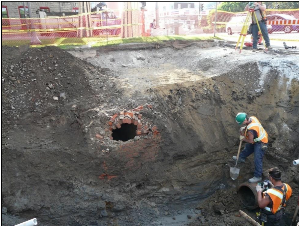
Photo 81. Vue d'ensemble de la sous-opération 2A en cours d'excavation et du vestige en brique 2A100, vers le sud-est (CeEt-884-2015-2-014)
