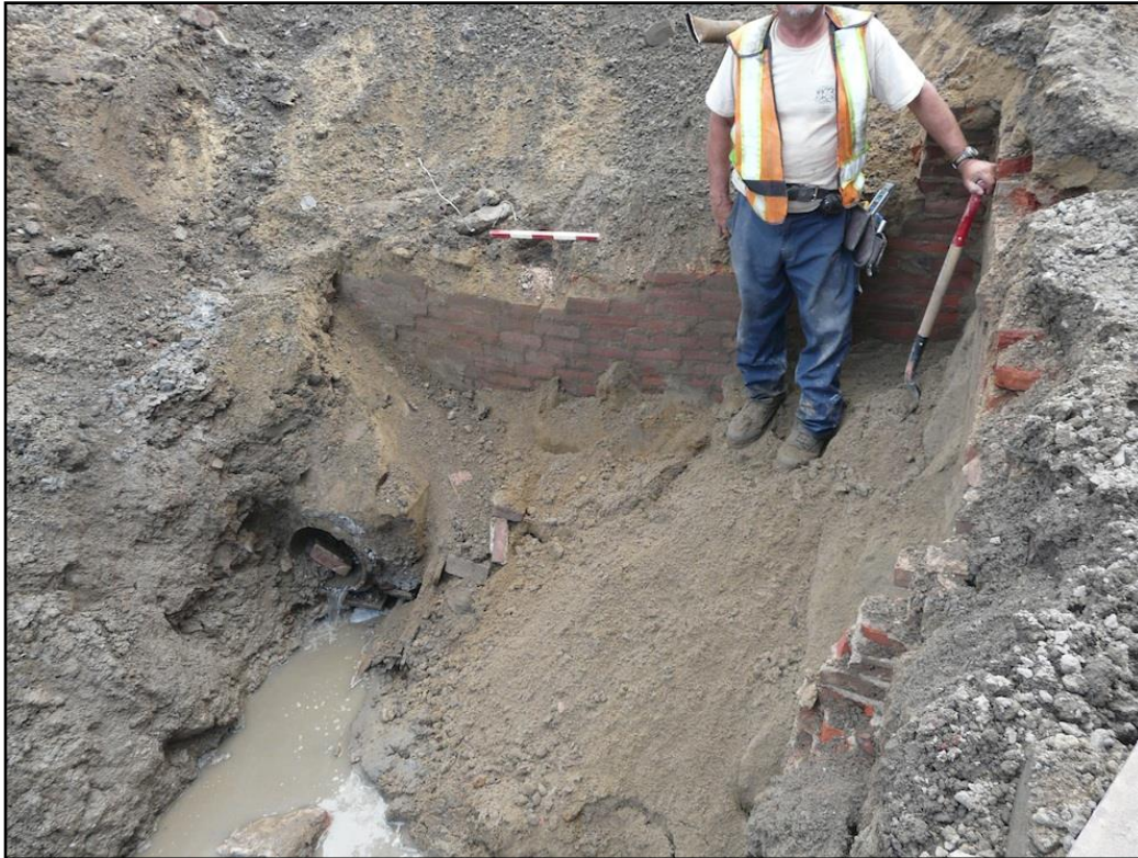
Photo 32. Vue de l'intérieur du vestige 1A103 correspondant à une chambre en brique remplie de sable, de tuyaux et de vannes et situé dans la voie ouest du boulevard Langelier, au sud du boulevard Charest, vers le sud (CeEt-931-2015-1-073)
