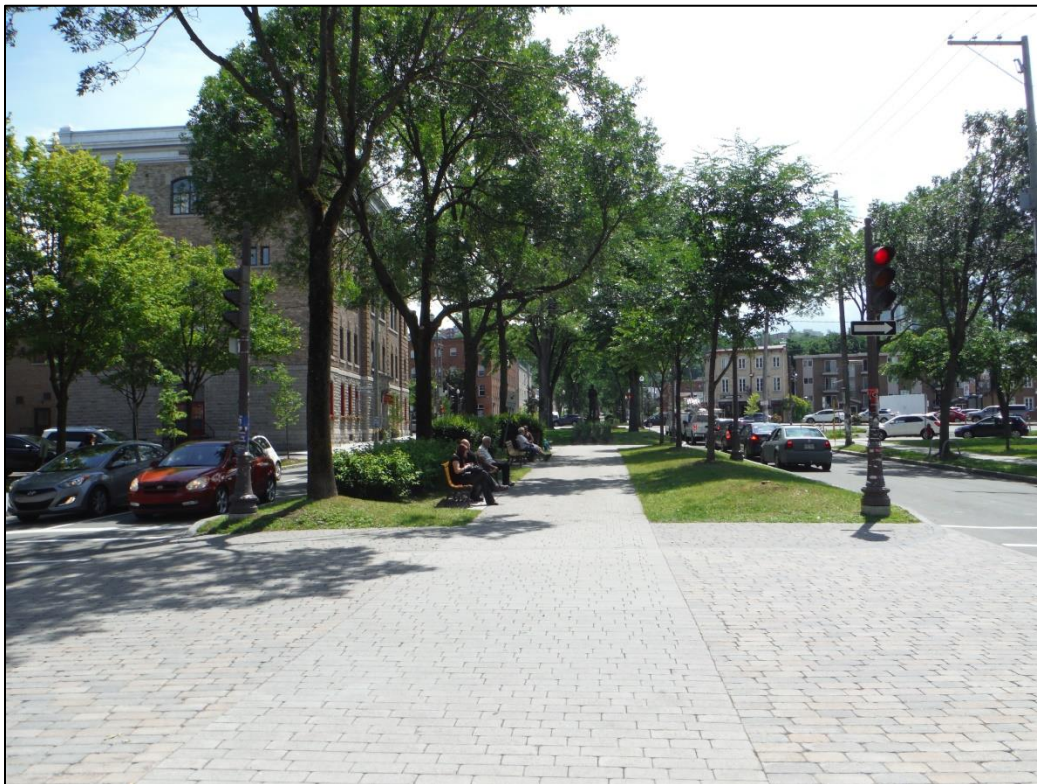
Photo 80. Vue d'ensemble de la portion du boulevard Langelier localisée entre le boulevard Charest au sud et la rue Notre-Dame-des-Anges au nord, vers le sud-est (CeEt-884-2015-2-001)
