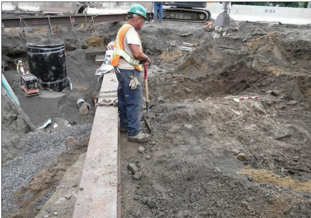
Photo 44. Sommet du conduit voûté en pierre 1A102 identifié sous un massif bétonné de Bell Canada dans la voie ouest du boulevard Langelier, au sud du boulevard Charest, vers le nord (CeEt-931-2015-1-061)
