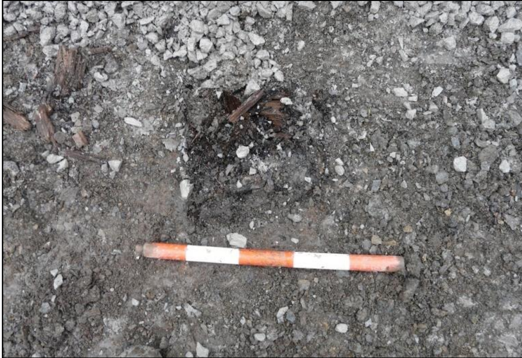
Photo 42. Vue détaillée d'un pieu de bois (1A105) mis au jour dans le terre-plein central du boulevard Langelier, près de la rue Franklin, en plongée (CeEt-931-2015-1-141)
