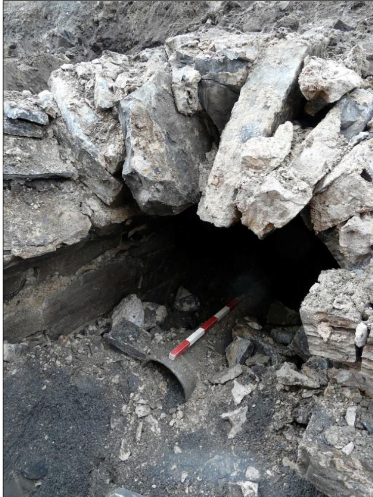
Photo 46. Vue de l'intérieur du conduit voûté en pierre 1A102 renfermant un tuyau en fonte, vers l'est (CeEt-931-2015-1-060)
