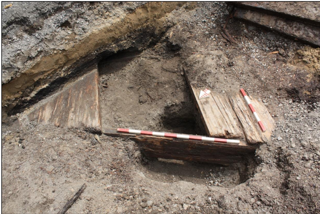
Photo 39. Vue d'ensemble du regard de bois 1A104 mis au jour à l'angle de la voie ouest du boulevard Langelier et de la rue Franklin, vers le sud (CeEt-931-2015-1-027)
