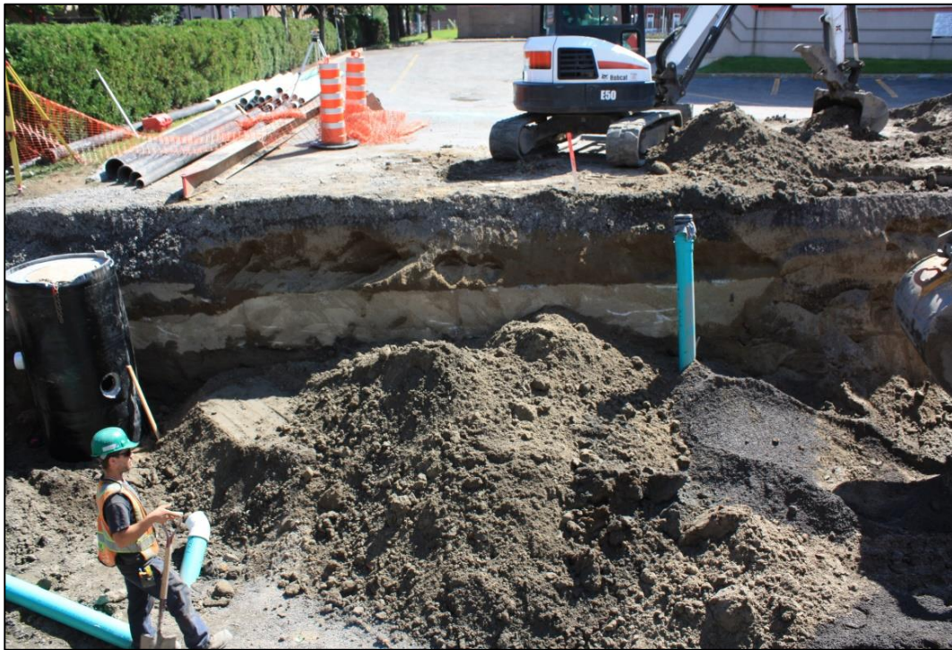
Photo 12. Massif bétonné mis au jour dans la portion sud de la rue du Chalutier, vers le sud-sud-est (2015-Chalutier-012)
