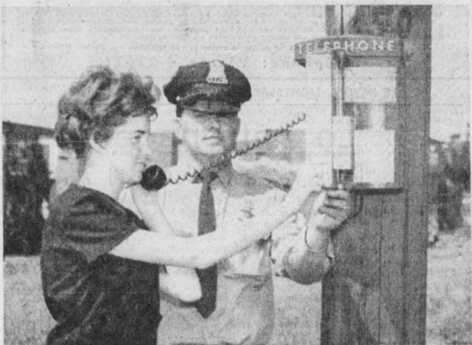
Voici la première des 600 boîtes téléphoniques d'urgence qui seront installées dans Montréal en vue d'accélérer la communication avec les services de la police et des incendies. Cette photo a été prise à l'angle des rues Appleton et Hudson, dans le district de la Côte-des-Neiges. (Photo Le Devoir)
