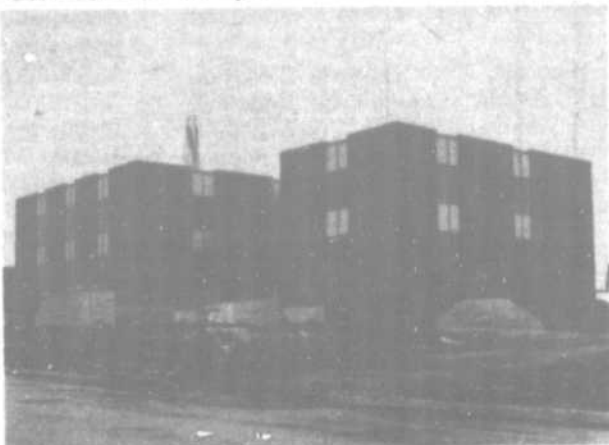
Le nouvel édifice du CLSC Lamater sur le boulevard des Seigneurs à Saint-Louis-de-Terrebonne accueillera la population dès la fin du mois de juin.
