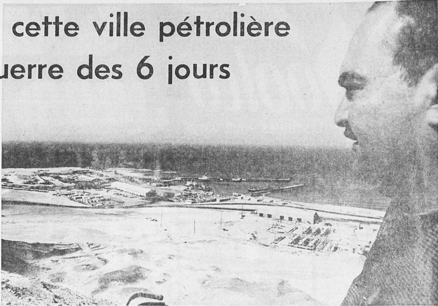
Mahmoud Allam, principal responsable des gisements pétroliers sous-marins de Morgan, contemple les installations de Ras Choukheir, sur la Mer Rouge. photos PA
