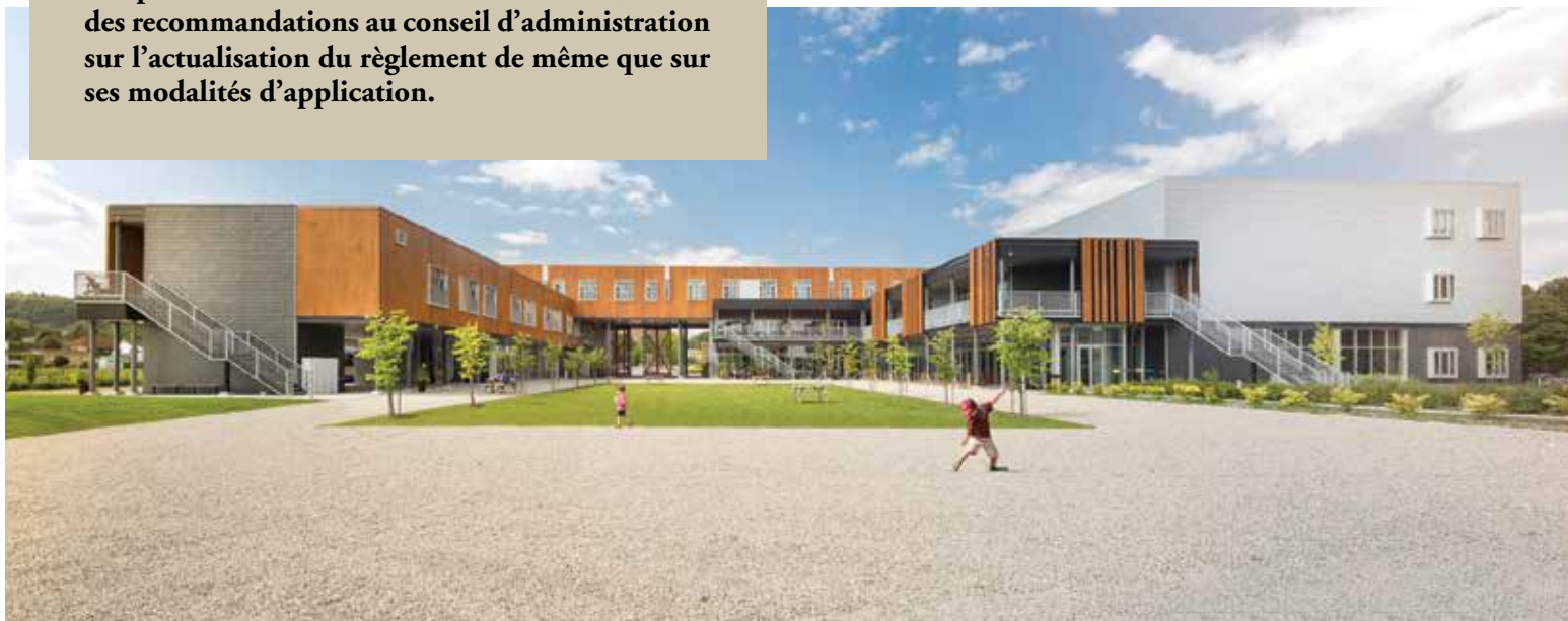
Hôtel La Ferme, Baie-Saint-Paul, Lemay Michaud, STGM architectes, Coarchitecture inc., en consortium Photo: Stéphane Groleau
