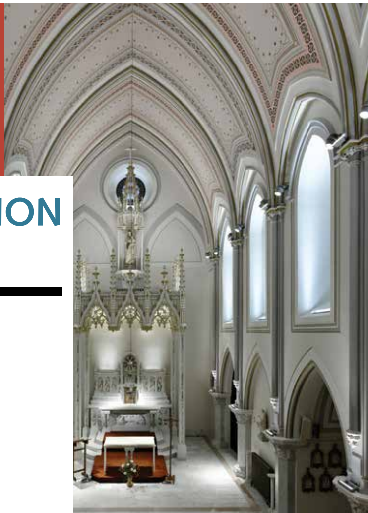
Restauration du Carmel de Montréal, Beaupré Michaud et associés architectes Photo : Pierre Bélanger
