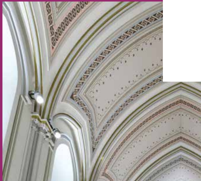
Restauration du Carmel de Montréal, Beaupré Michaud et associés architectes Photo : Pierre Bélanger
