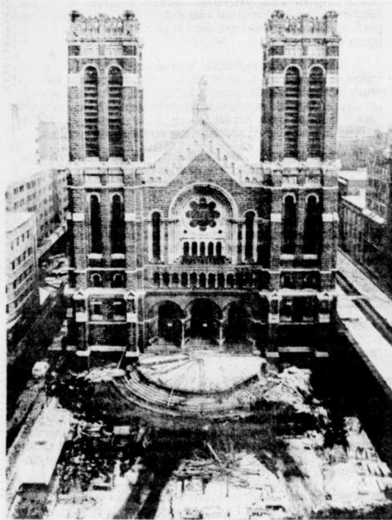
À 15 pieds des fondations de l'église St-Roch, un stationnement souterrain a été excavé en 1975.
