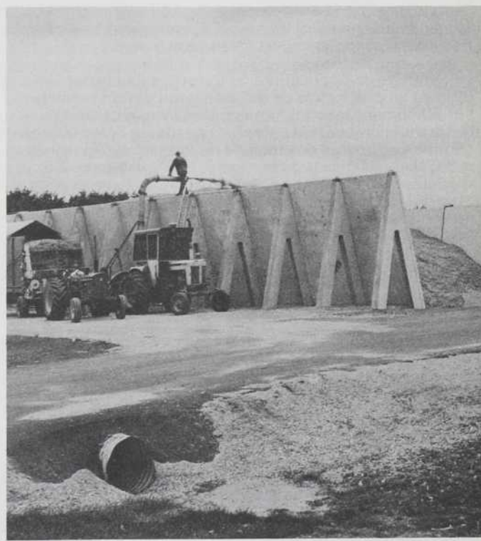
▲ DES SILOS À L'HORIZONTALE — On a récemment construit deux silos horizontaux à la Ferme expérimentale d'Agriculture Canada, près d'Ottawa. Chaque tranchée mesure 40 mètres de long, 10 mètres de large et 5 mètres de haut. Construites en béton, chaque section est facilement remplaçable en cas d'avarie. La capacité de chaque silo est de 450 tonnes de luzerne, ce qui équivaut à la production de deux coupes sur 50 hectares. Des essais, présentement en cours, visent à déterminer l'état de l'ensilage et ses pertes éventuelles en valeur nutritive.
