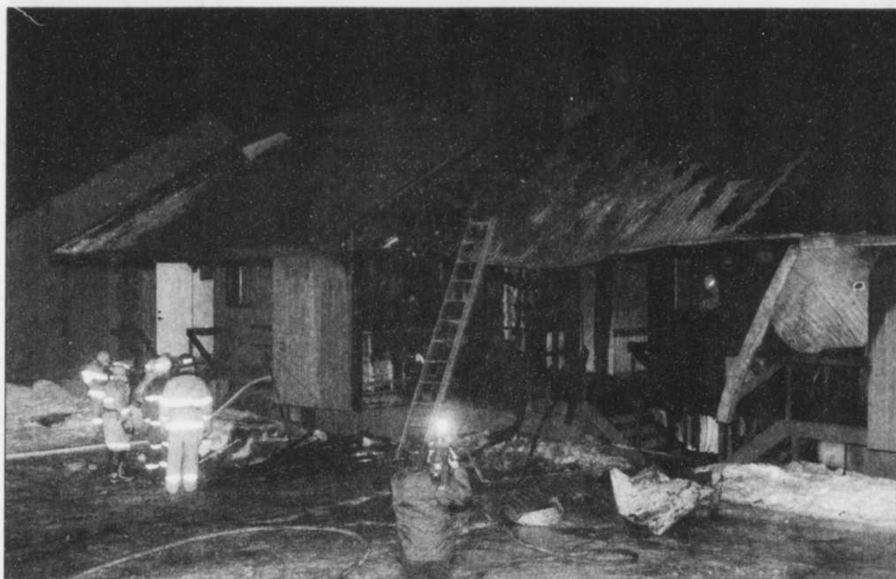
Les locataires auraient déposé des cendres chaudes sur le perron calciné ci-dessus. Le feu s'est par la suite propagé à trois autres condos par l'entrevoil.
