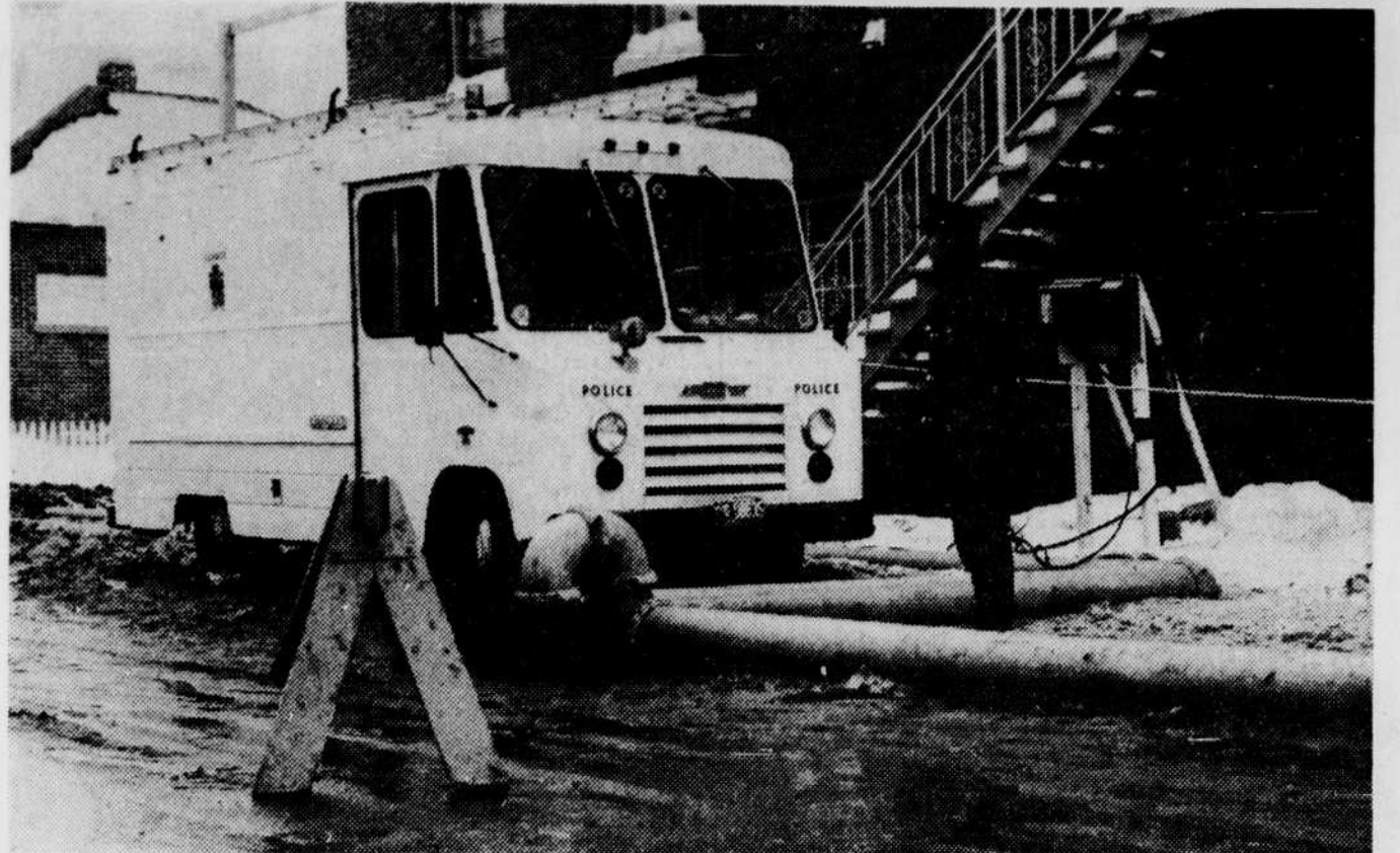
Des tuyaux ont été installés pour "vider" les égouts de surface de la zone sinistrée à Asbestos, afin d'éviter qu'un nouvel affaissement ne se produise. Ces tuyaux s'étendent sur une longueur de 500 à 600 pieds et déversent l'eau dans un autre égout, hors de cette zone. (Photo La Tribune, par Studio Fréchette)
