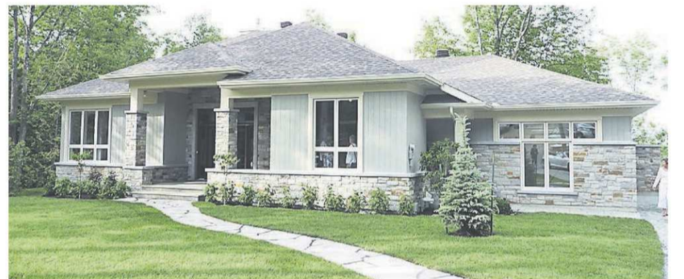
L'une des plus belles réalisations de Construction M.F. Guillemette, une résidence prestigieuse certifiée Novo-Climat et située à Ayer's Cliff.
