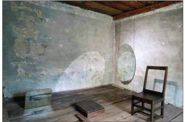
L'artiste Caroline Gagné a réalisé une installation dans la chambre-cabane, pièce où la patine et l'usure des finis ont été conservés.
