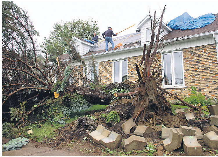
PHOTO FRANÇOIS GERVAIS, LE NOUVELLISTE Une tornade de force 0 (avec des vents allant de 60 à 120 km/h) a causé bien des dégâts dans le quartier Des Chenaux à Trois-Rivières comme ici, où un arbre a cédé sous le vent.
