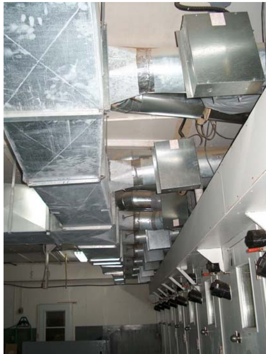
Figure 2 : Circuit de ventilation et de chauffage
