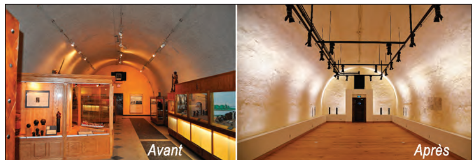
L'intérieur de la poudrière avant et après les restaurations.
