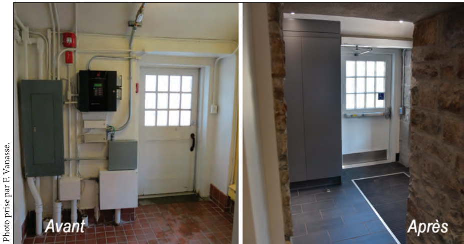
Le hall d'entrée avant et après les restaurations.
