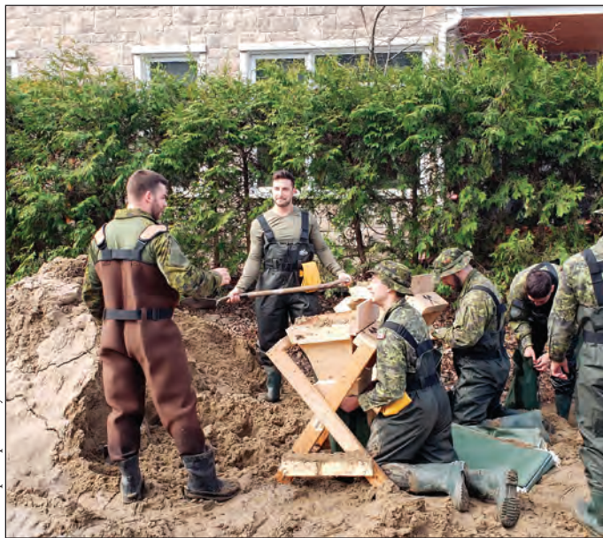
Membres du 6 e Bataillon au sein de la CIN occupés à construire et à fortifier une digue à Pierrefonds.
