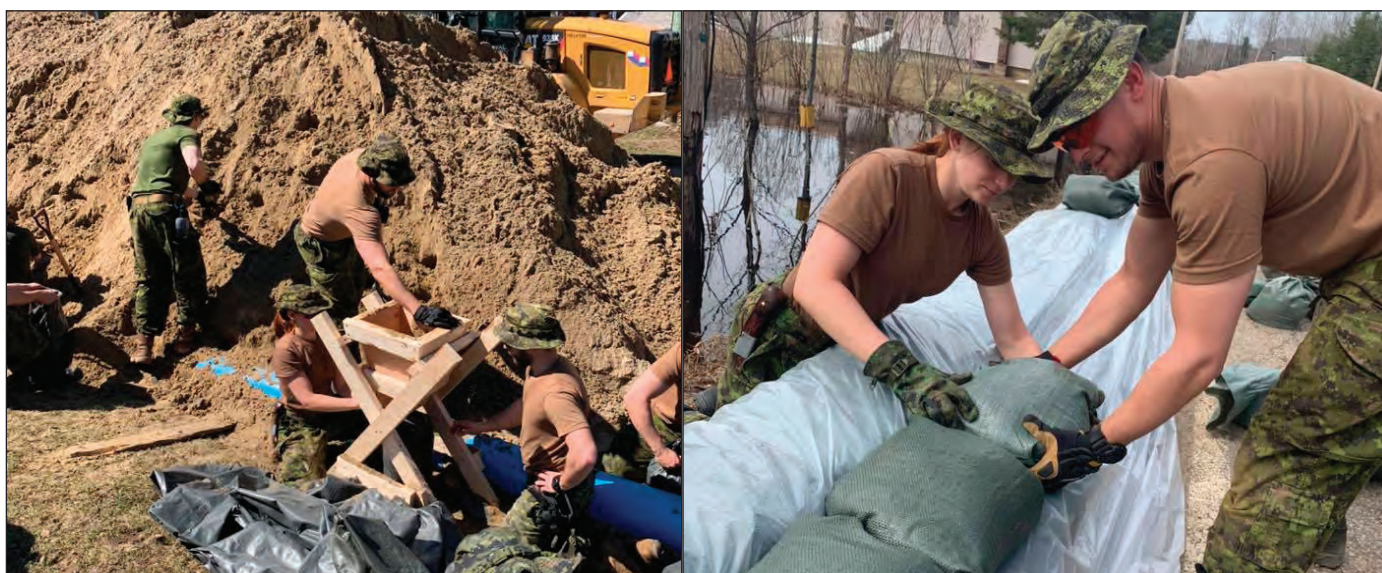
Lors de l'OP LENTUS, les pionniers construisent des barrages.
