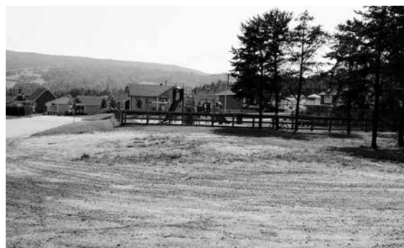
Avec le nouveau tracé du boulevard Kane, la Ville pourra procéder l'an prochain à l'asphaltage du réseau, éliminant ainsi les poussières de sable, et au réaménagement du parc du Ravin.
