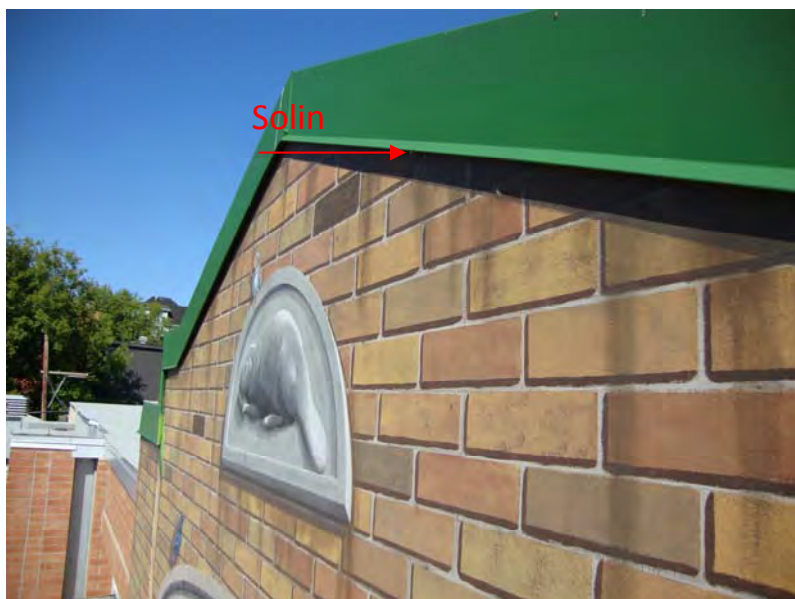
Détail de la fresque L'hôtel des voyageurs , de Serge Malenfant, du groupe Murales urbaines à revitalisation d'immeubles et de réconciliation sociale (M.U.R.I.R.S.) , montrant un solin qui empêche l'eau de s'infiltrer dans le mur. (page consultée le 24 avril 2013)
