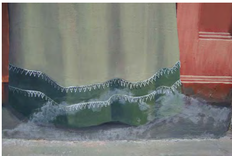
Détail de la Murale du bicentenaire de Sherbrooke , du groupe M.U.R.I.R.S. montrant des efflorescences blanchâtres résultant de sels déposés sur la surface du mur; elles sont causées par la migration de l'eau et de la vapeur d'eau entraînant des sels de déglacage.
