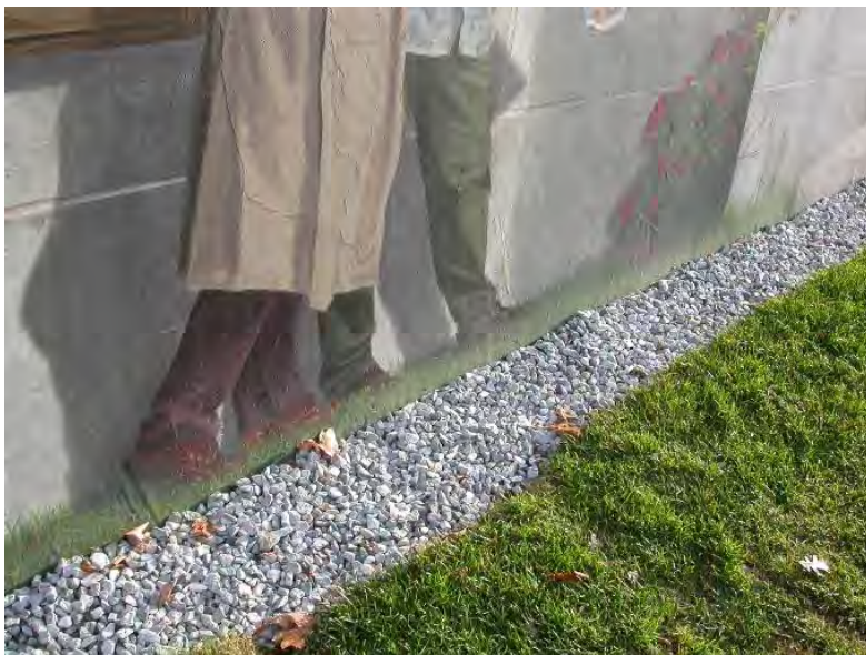
Détail de la fresque Cinquante ans à notre image (2009), du groupe M.U.R.I.R.S. Une zone de propreté au pied du mur freine l'accumulation de saleté et la croissance de végétaux. Par contre, il aurait été préférable de laisser une distance entre le niveau du sol et le début de la peinture.
