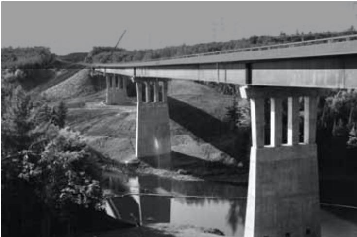
Léonard Infrastructures de transport Pont rivière de la Petite-Nation sur l'autoroute 50 à Lochaber
