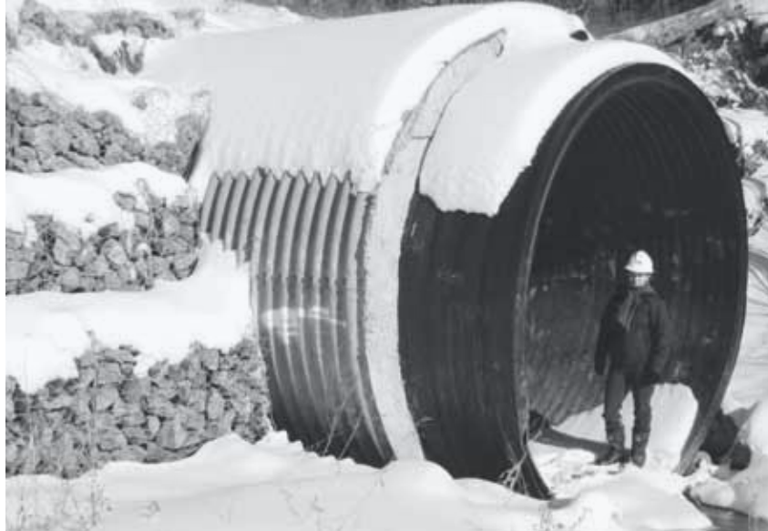
Léonard Relève du génie-conseil Insertion du ponceau du ruisseau Moreau sous l'autoroute 50 et le boulevard Gréber à Gatineau par Julie Archambault, ing. jr
