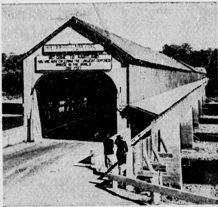
Le pont couvert de Hartland, Nouveau-Brunswick, est le plus long de ce genre au monde. Personne cependant ne regretterait sa disparition, car les citoyens de Hartland le considèrent comme un danger d'accident. (Photo S.N.S.)
