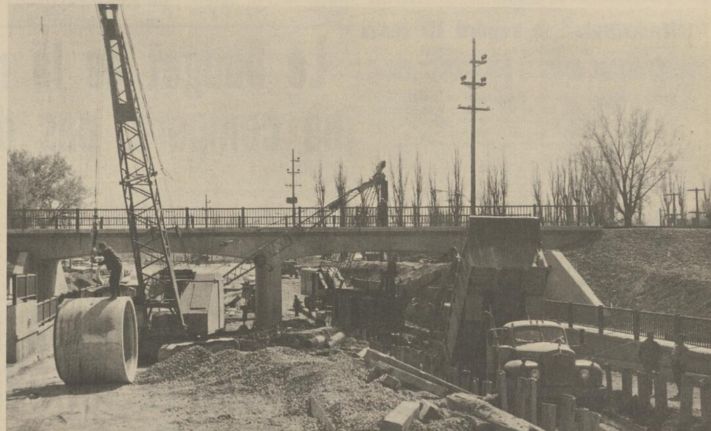
La construction d'égouts pluviaux et auxiliaires et de l'usine de pompage à Saint-Jean s'accroît. Ce projet de $2,485,000, entrepris par la cité sera vraisemblablement terminé d'ici la fin de la présente année. On voit ici sur la photo, des ouvriers ainsi que la machinerie lourde poser des tuyaux dont le diamètre varie de 94 pouces et plus en-dessous du viaduc du Canadien national.
