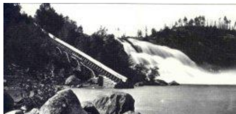
L'imposante chute de High Falls sur la Lièvre et la glissoire en bois longue de 130 mètres pour éviter que le bois carré se brise au pied de la chute.
