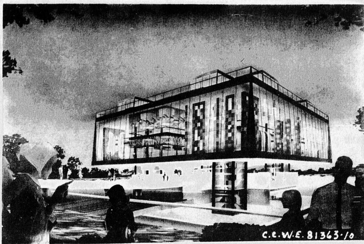
LE PAVILLON DU QUEBEC est unique sur l'emplacement de l'Expo 67: Il est construit sur l'eau. Il s'agit d'une structure d'aspect massif, mais allégée par le matériau utilisé, le verre. Il a 50 pieds de hauteur et sa base couvre 25,000 pieds carrés de terrain. Le pavillon du Québec est situé entre celui de l'Ontario et celui de la France.
