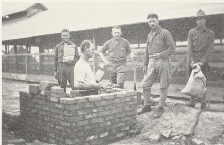
La construction du four de la compagnie
