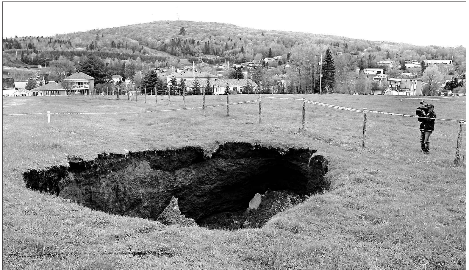
Le ministère des Transports a réalisé 27 forages dans le sol, l'été dernier, autour de l'endroit où les trous sont apparus, dans Charlesbourg. Il y a bel et bien trouvé un lambeau de calcaire, enfoui sous une épaisse couche de dépôts meubles. — PHOTOTHÈQUE LE SOLEIL, JEAN-MARIE VILLENEUVE
