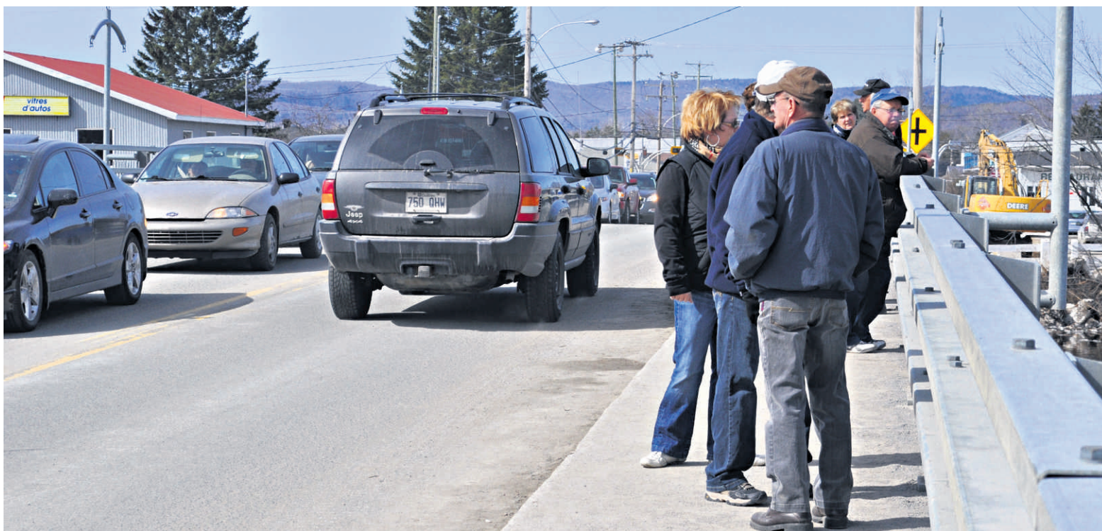
Le niveau d'eau de la rivière Sainte-Anne a suffisamment baissé pour permettre la réouverture du pont Chalifour.
