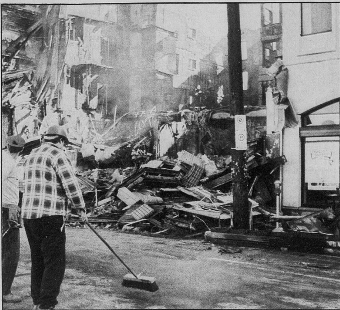
On donnait hier les premiers coups de balai pour nettoyer les environs de l'immeuble du 264, rue Rideau qui a été rasé par un incendie dans la nuit de samedi à dimanche.
