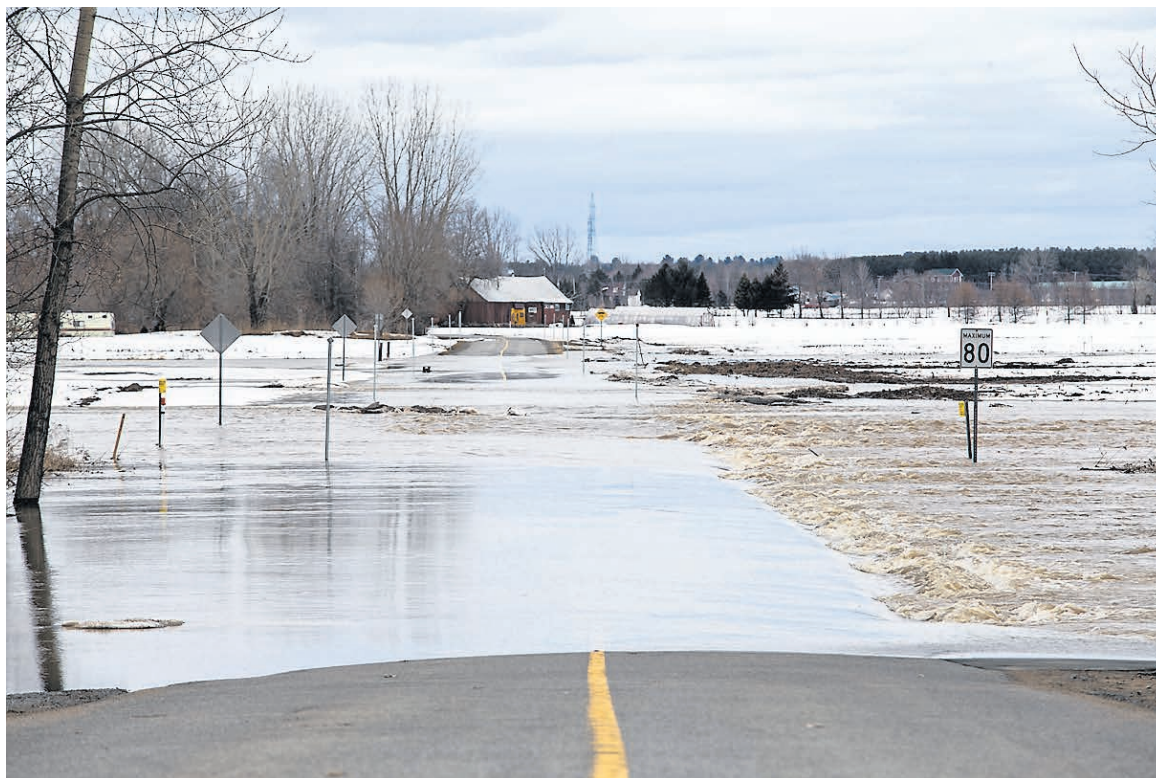
L'eau recouvrait ce week-end une partie du boulevard du Danube à Bécancour. — PHOTO: OLIVIER CROTEAU
