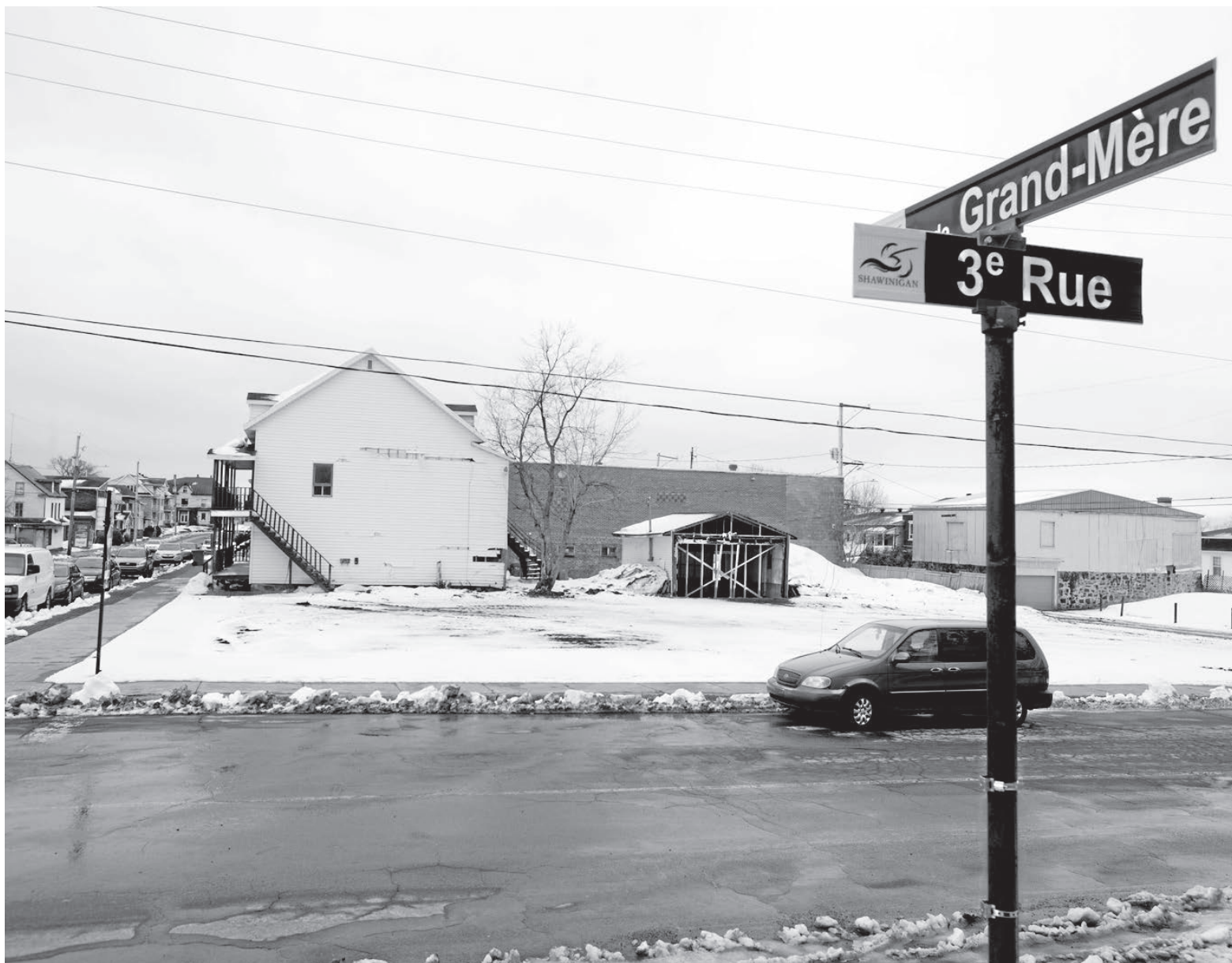
La démolition de l'ancien hôtel de La Salle s'est déroulée rondement. Le terrain situé au coin de l'avenue de Grand-Mère et de la 3 e Rue est maintenant débarrassé du vétuste immeuble. —PHOTO: STÉPHANE LESSARD.
