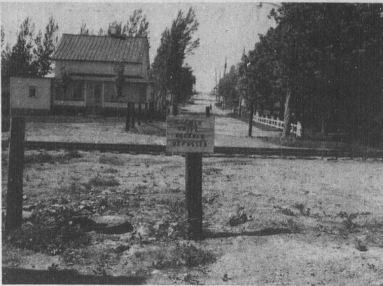
CHEMIN PRIVE DEFENSE DE PASSER. C'est ce peut lire l'automobiliste qui emprunte une certaine rue de Sainte-Hénédine. Les résidents de Sainte-Hénédine ont à cet effet baptisé cette rue "Rue du rideau de fer". Cette rue avait été fermée par la municipalité vu le danger causé par la voie ferrée qui traverse cette artère secondaire.
