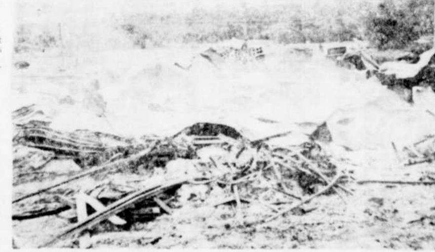
GARAGE ET HANGAR DETRUIT. — Le garage et la remise qui se trouvaient à quelque 50 pieds de la maison ont également brûlé de fond en comble, avec tout son contenu d'une valeur considérable. Tous les accessoires du tracteur de M. Cyr, ainsi que des lits et meubles ont été détruits, pour ne laisser à la famille, que la maison. La famille Cyr compte six enfants, et quatre enfants du Bien-Etre social ainsi que le père et la mère. (Photo La Tribune, par Mme G. Pomerleau)
