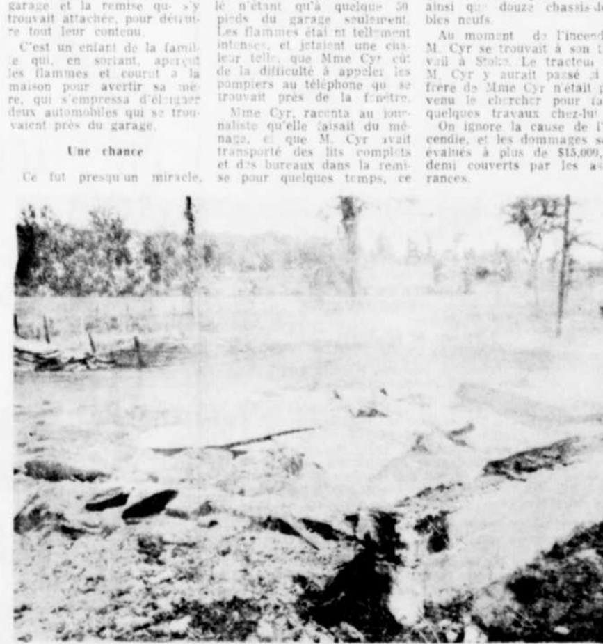
AMAS DE CENDRE — Voici ce qui reste de la grange et de l'étable de M. Victor Cyr, demeurant à RR. no 1 à quelque trois milles d'East Angus, après que l'élément destructeur a fait son œuvre. Seulement deux tonnes de foin ont brûlé, vu que le propriétaire n'avait pas fini la récolte. (Photo La Tribune, par Mme G. Pomerleau)
