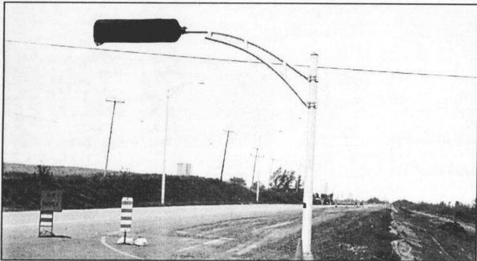
Les automobilistes qui empruntent la route 116 entre Princeville et Plessisville doivent user de patience. Les travaux d'aménagement de voies supplémentaires à la sortie de Princeville seront terminés d'ici un mois.
