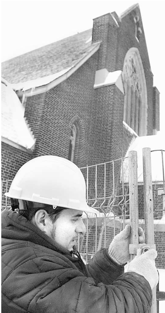
La petite église St. Luke, située à l'angle des rues Holt et de la 8 e Avenue, à Rosemont, est finalement tombée sous le pic des démolisseurs.
