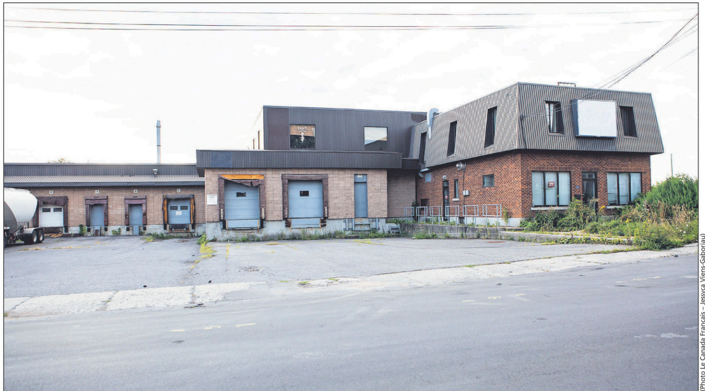
La démolition de l'usine et la construction des nouveaux logements ne devraient pas commencer avant un an.
