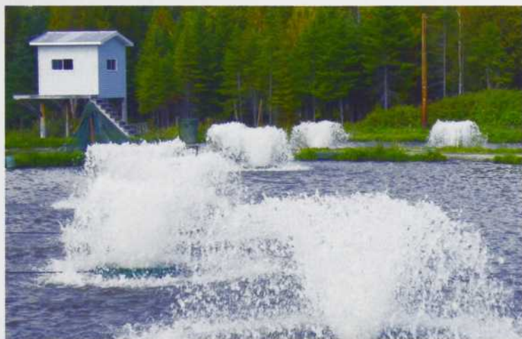
Bassins d'élevage d'ombles de fontaine avec des aérateurs (Chartierville, Québec).
