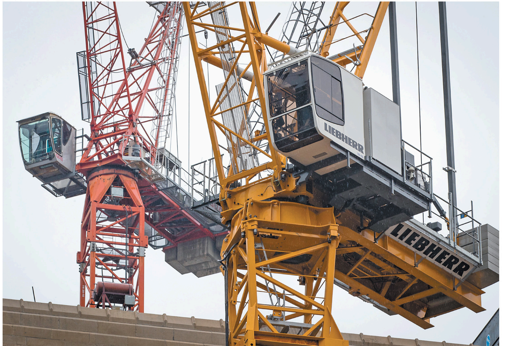
Les moyens de pression ont débuté jeudi dernier au chantier du nouveau pont Champlain entre Montréal et la Rive-Sud. Lundi, la grève s'est généralisée à plusieurs chantiers du Québec.
