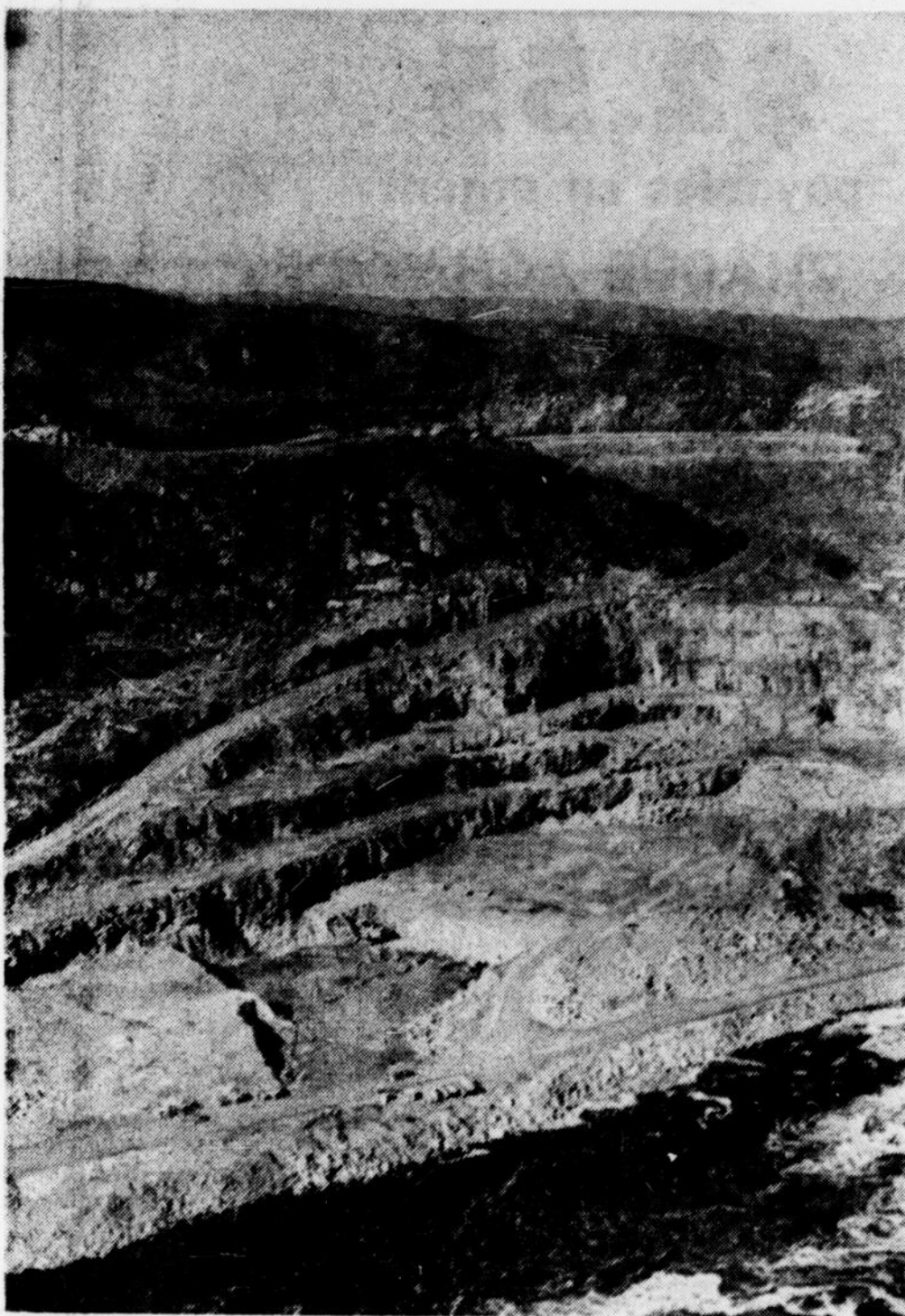
Une montagne qu'on a littéralement broyée pour construire le barrage Outardes 4, que l'on aperçoit à l'arrière-plan.
