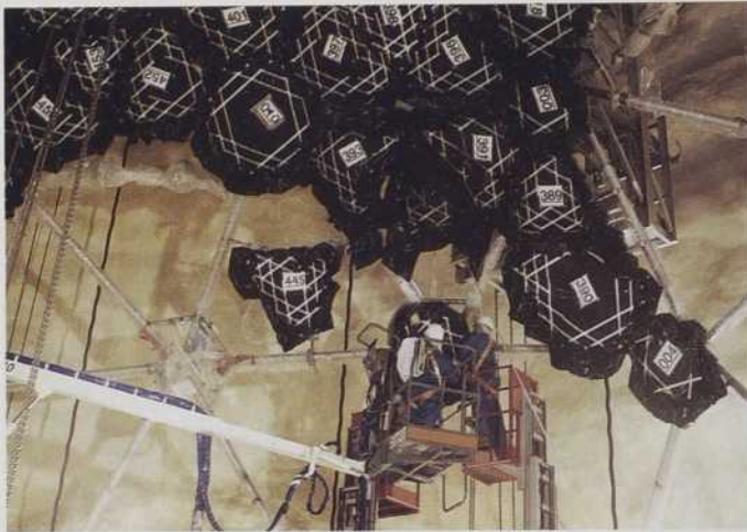
Installation de sections de photomultiplicateurs dans le SNO. Chacun de ces photomultiplicateurs peut apercevoir une chandelle allumée sur la Lune.
