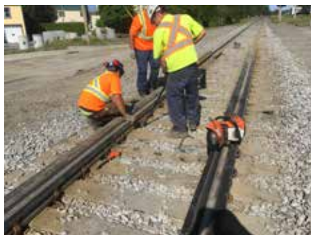
Pose des ornières de caoutchouc au passage à niveau de la rue Frontenac.
