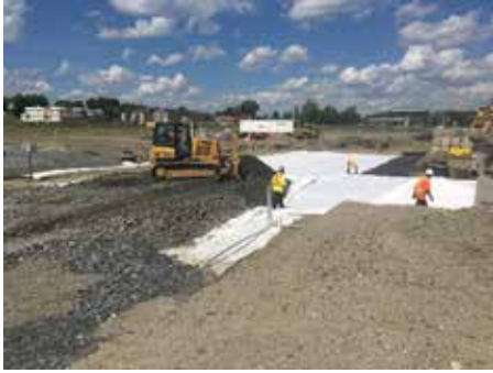
Installation de la membrane destinée à maintenir une bonne structure de rue.
