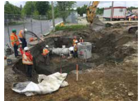
Installation de la sortie du bassin de rétention vers le lac Mégantic.
