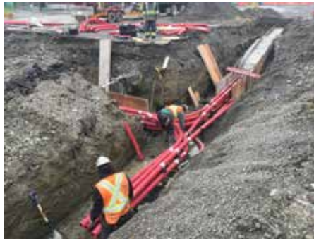
Construction de massifs pour l'installation des câbles électriques et de télécommunications.
