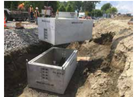
Mise en place d'un puits d'accès pour l'installation des câbles électriques et de télécommunications.
