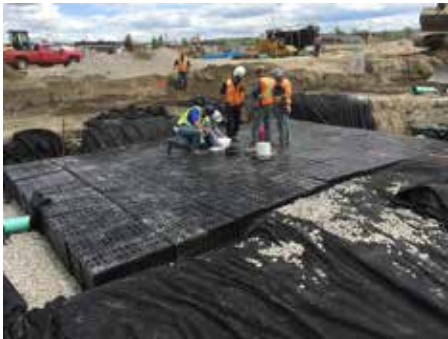
Construction d'un bassin de rétention des eaux souterraines dans le nouveau rond-point.
