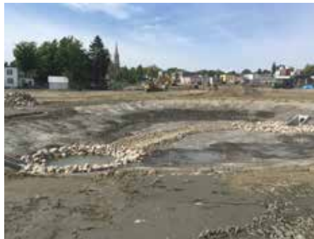
Bassin de rétention, à ciel ouvert, des eaux de pluie. Des végétaux seront installés au début de l'automne.
