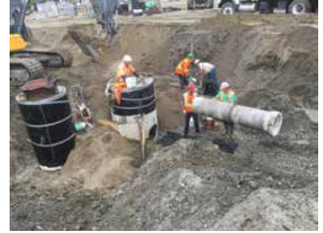
Arrimage de conduites pluviales à un puits de regard.
