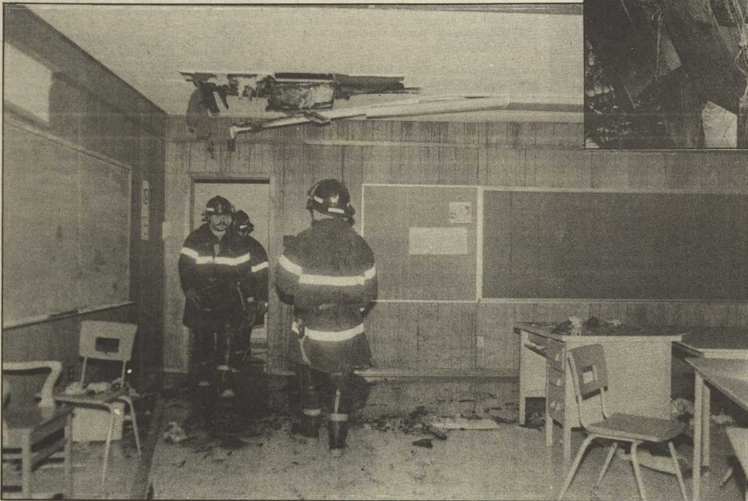
Pour accéder aux flammes, les sapeurs ont dû percer le plafond de tuile en maints endroits.
