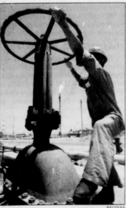
Un travailleur ouvre un pipeline.
