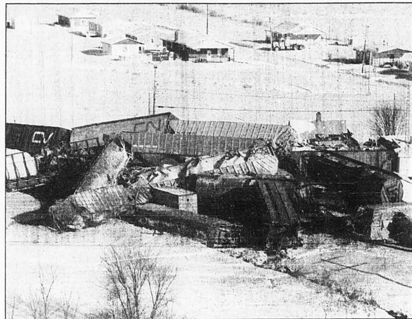
L'accident est survenu au centre du village, en arrière de l'église, à la hauteur d'un passage à niveau très fréquenté. Sous le choc, les wagons se sont empilés, endommageant sérieusement deux maisons.
