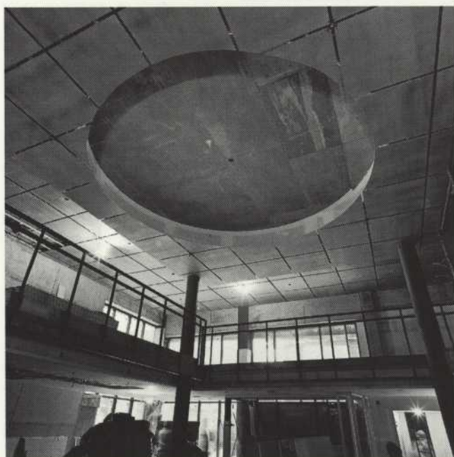
Vue du hall d'entrée
