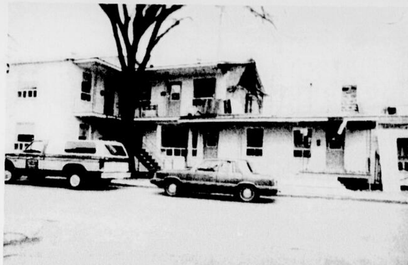
Le projet Fournier, à Montmagny est déjà dans les faits plus avancé que sur cette photo prise au début de la semaine dernière.
