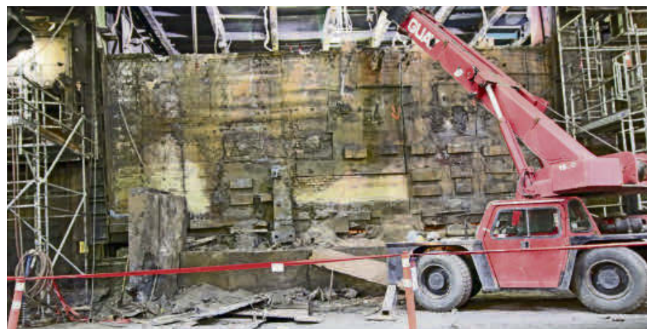
Une plaque de plaque de métal s'est détachée de la structure sur laquelle travaillait la victime, le 26 avril 2018. Photo CNEST
