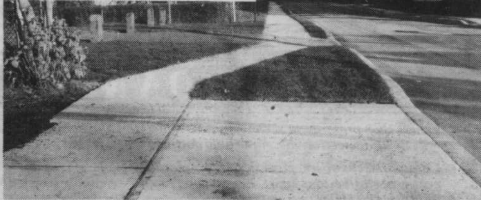
Rue Labonté (près de Brais) à la hauteur de la piste cyclable: on voit ici les bordures et les trottoirs refaits, ainsi que les correctifs paysagers (gazonnement) et le nouvel accès à l'entrée de cour.
