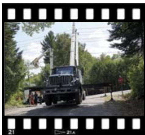
Grue d'Hydro-Québec en position.
