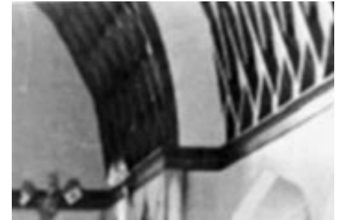
Structure autoportante Art déco du toit rond de l'église de Saint-Hippolyte.
