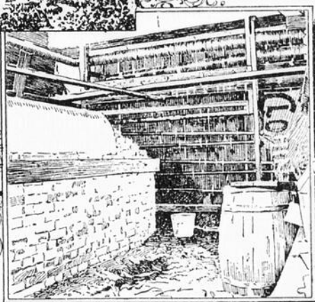
Bouilloire et partie du condenseur.
