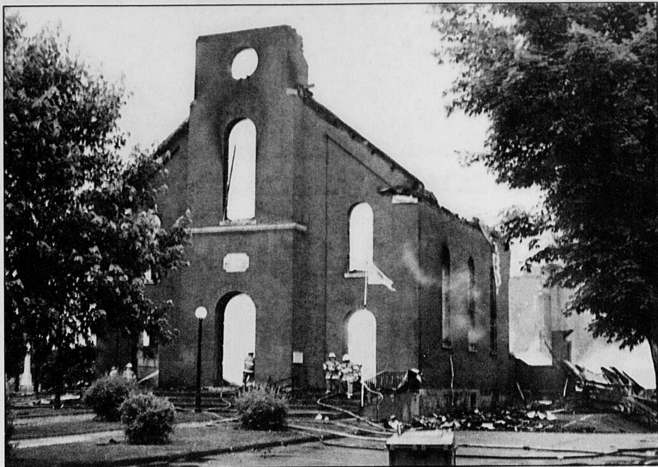
Les pompiers de Danville ont consacré d'importants efforts à combattre l'incendie à l'église Sainte-Anne.
