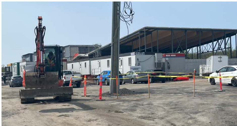
La nouvelle école de Carignan est présentement en construction et ouvrira ses portes pour la rentrée scolaire 2024. (Photo : archives)
