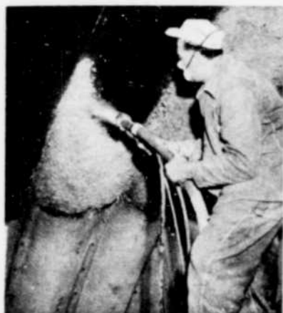
On a isolé les murs contre le froid en les revêtant de mousse d'amiante pulvérisée (vignette de gauche), ce qui aide aussi à dissimuler l'aspect métallique du côté intérieur des murs et du toit, faits d'arches d'acier dont la vignette du bas montre l'assemblage.
