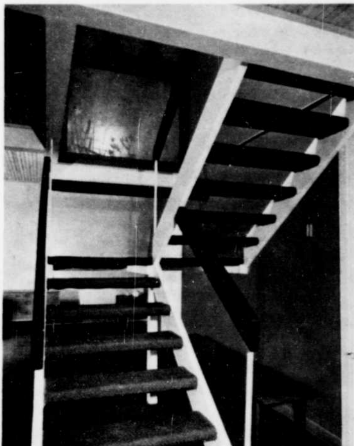
L'escalier intérieur est suspendu au toit par de longs montants. Son profil aérien est encore accentué par un panneau mural lumineux sur le palier.
