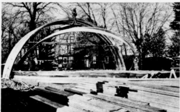
On a isolé les murs contre le froid en les revêtant de mousse d'amiante pulvérisée (vignette de gauche), ce qui aide aussi à dissimuler l'aspect métallique du côté intérieur des murs et du toit, faits d'arches d'acier dont la vignette du bas montre l'assemblage.
